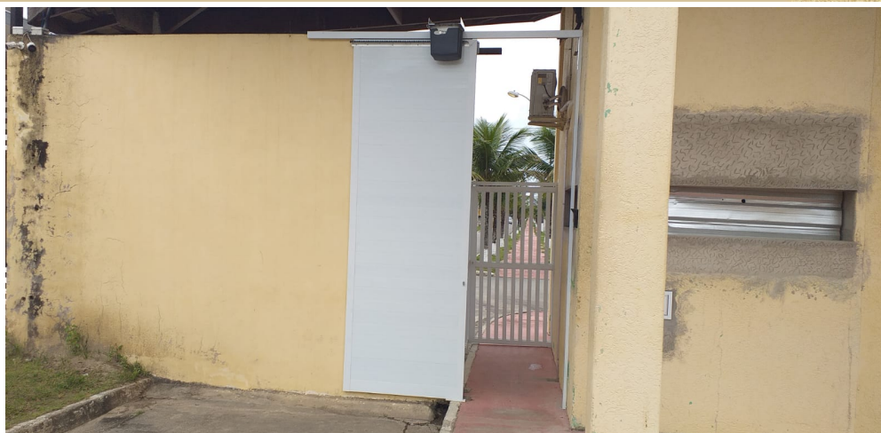
Portão automatizado para pedestres e ciclistas. Vista do exterior
