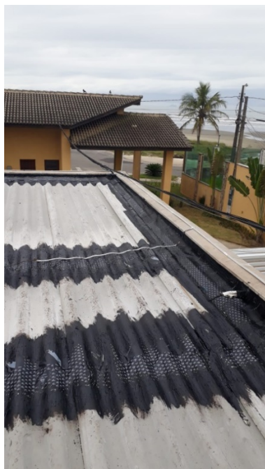
Aplicação da manta asfáltica
