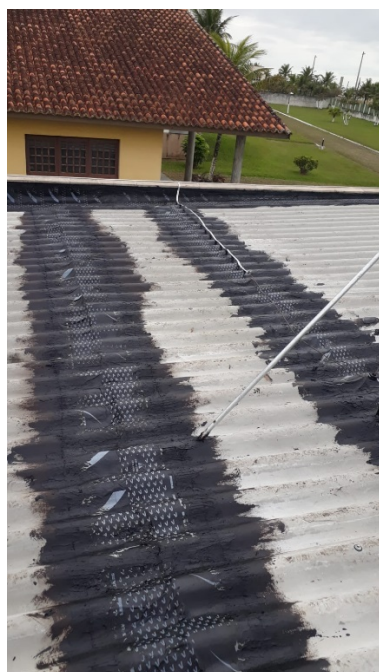
Aplicação da manta asfáltica
