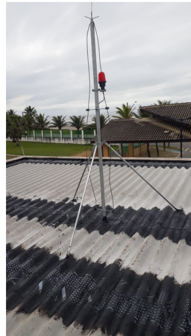
Reinstalação do para-raios
