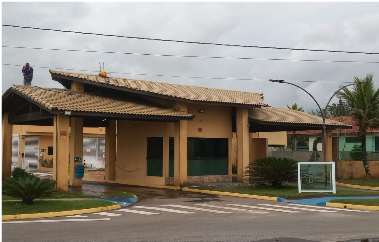
. Lavagem do telhado da antiga Portaria Social
